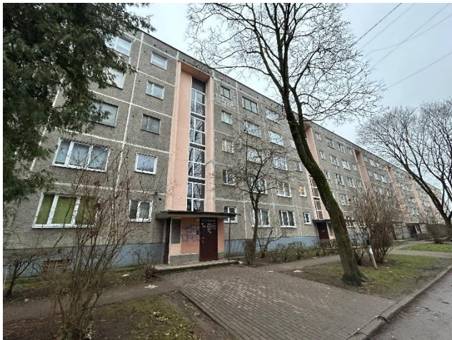
1. - 3. attēls. Ēkas fasādes.
